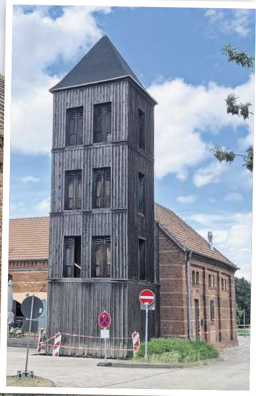
Zwischen Mai und Oktober wurde der Schlauchturm am Walter-Schulz-Platz saniert. Fotos: Stadt Wittstock/Dosse, Björn Wagener
