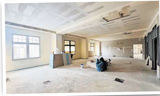
Blick ins innere des ehemaligen Kaufhauses: hier wird eifrig gebaut. Fotos: Martin Ferch
