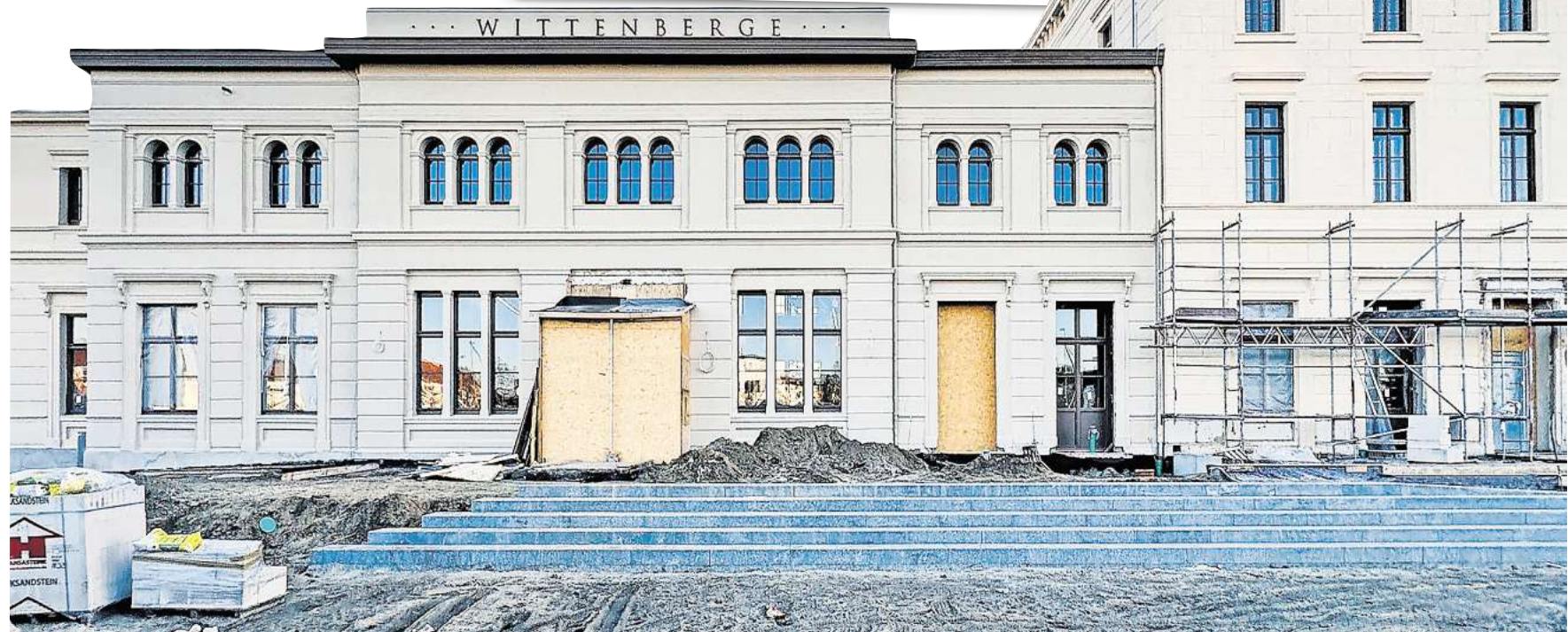
Das Bahnhofsgebäude in Wittenberge wird im Juni nach der Sanierung offiziell eingeweiht. Fotos: Martin Ferch
