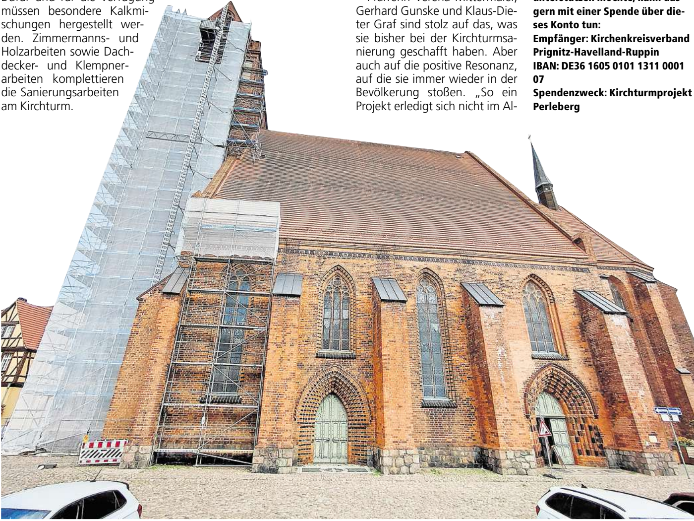
Der Kirchturm der Sankt-Jacobi-Kirche bleibt eingerüstet. Bis Ende November läuft der zweite Bauabschnitt der Sanierung. Foto: René Hill/Stadt Perleberg
